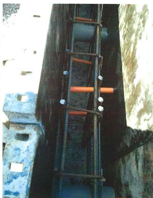
Fotografía N° 4 – 17/11/2015: Ejecución de confinamiento en discordancia con lo graficado en planos de corte.
