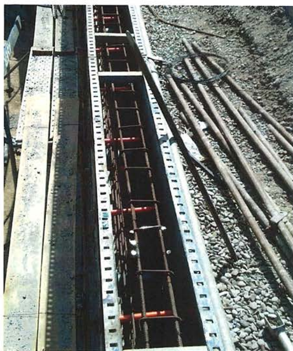
Fotografía N° 3 – 17/11/2015: Ejecución de confinamiento en discordancia con lo graficado en planos de corte.
